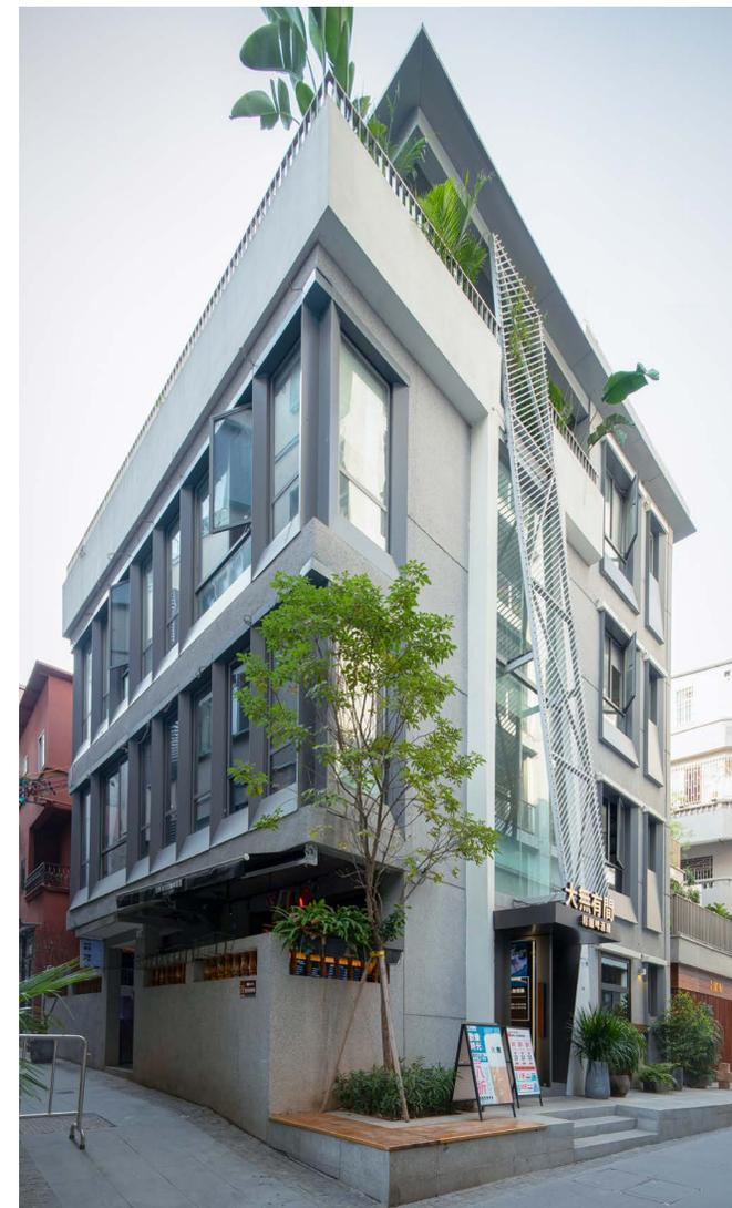
在“缝隙楼”的改造中，设计师挖掘出了东侧巷道这个被忽略的场地要素，以悬浮的银色金属百叶遮阳板作为与之对话的媒介，将场地的力量反作用在建筑主体之上，形成立面的不规则形状的东侧开口。
